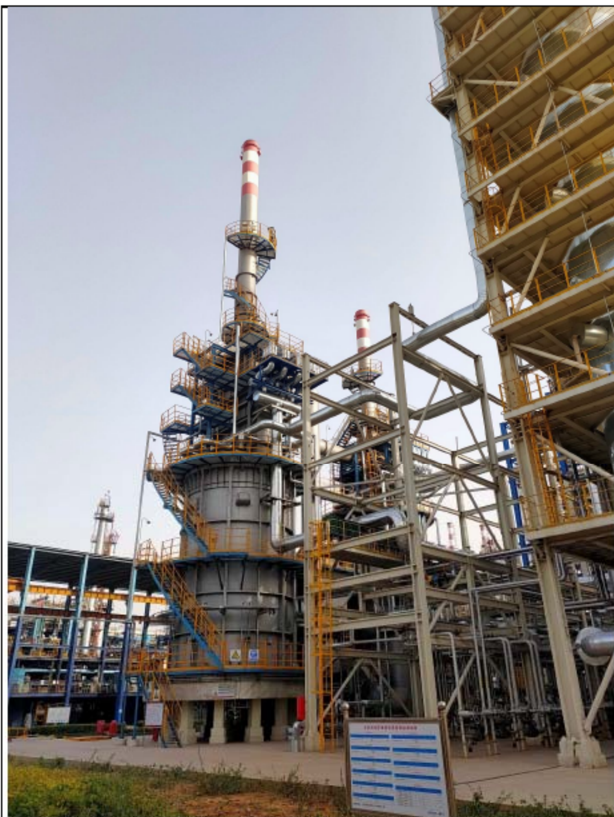
反应加热炉烟气、分馏加热炉烟气共用排气筒（左侧排气筒，右侧排气筒已停用）
